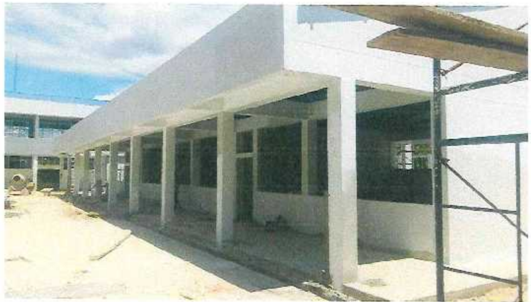
PINTURA LATEX – AULAS
