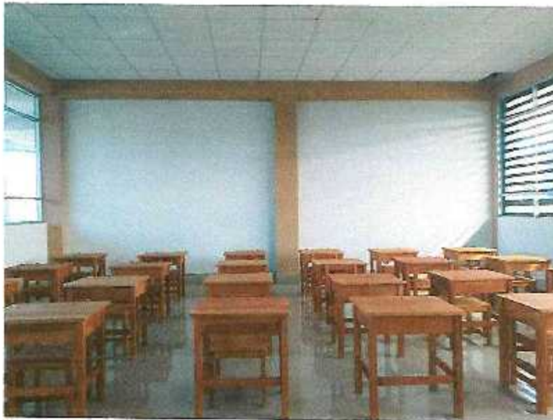
PINTURA LATEX AULAS - INTERIOR
