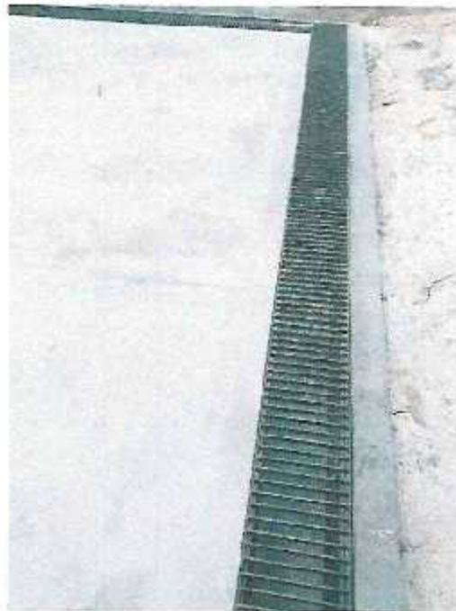
REJILLA EMPOTRADO EN CUNETA DE MORTERO
