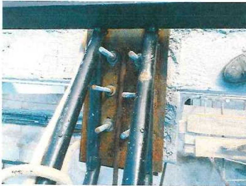
ESPARRAGOS Y PLANCHA METALICA PARA CORREAS DE TECHO LOSA DEPOTIVA
