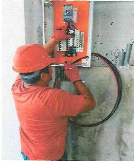
INSTALACION DE TABLEROS DE DISTRIBUCION
