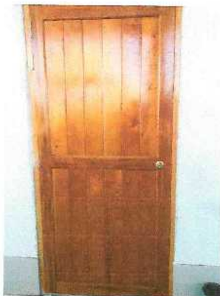
PUERTA DE MADERA MACHIMBRADO ABRE A 90°
